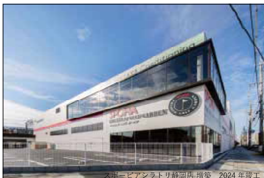
スポーツピアナトリ静岡店 増築 2024年竣工
