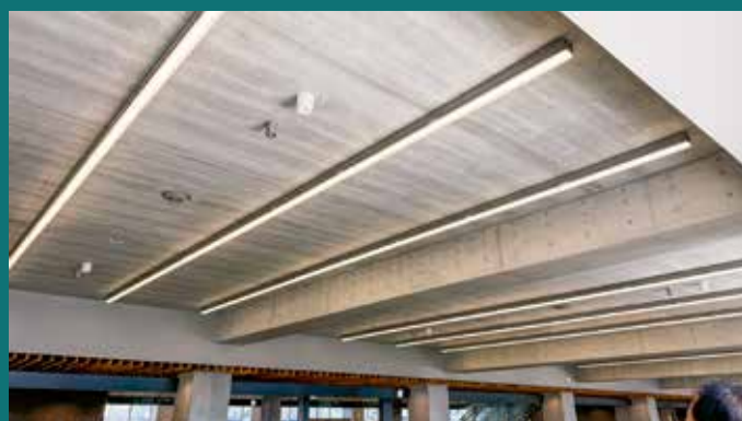
執務室フラット天井
